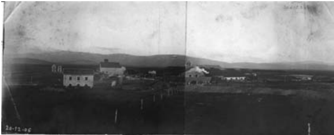
20 de diciembre de 1906. Panorámica con el chalet en construcción, la estación de Arija con su rótulo ya puesto y un tren de vapor delante de ella, las naves de la fábrica y la grúa a la derecha.
