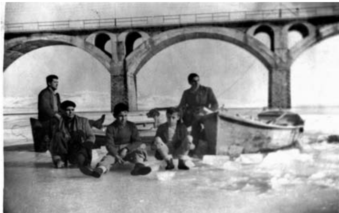
Puente NogueroI y pantano helado en un invierno de principio de la década de 1950.
