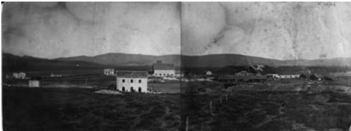
Vista panorámica con dos fotografías yuxtapuestas. Se pueden ver las casas de Rámila ya terminadas, así como otras a su derecha e izquierda. Al fondo a la izquierda La Riva, y en el centro La Población. Por la zona de la fábrica, ya está más avanzado un chalet, y levantado gran parte de la nave izquierda. La carretera llega derecha a la fábrica, siguiendo en línea recta el trazado del puente. 22 de noviembre de 1906.
