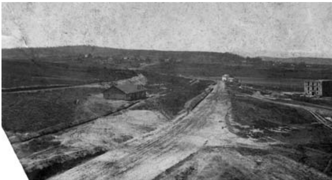
Carretera de Vilga a Arija. Al fondo se ve Arija y Bimón. La casa en construcción es la de Ugarro-Calle. La de la curva es la cantinuca de Moisés. Año 1906.
