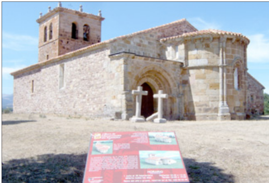
Vista exterior del Centro de Interpretación del Románico en Villacantid.
