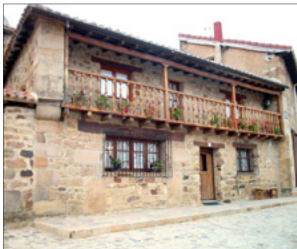
Casa restaurada y calle empedrada.
