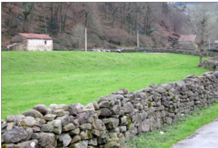
Muro de piedra frecuente en los pueblos cántabros.
