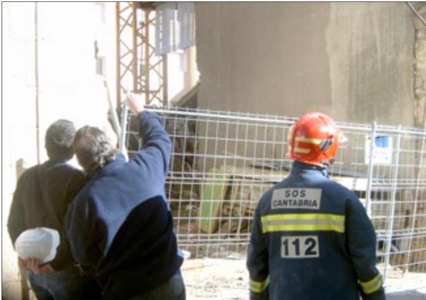
Miembros del 112 observan los daños del edificio que se derrumbó en parte.
