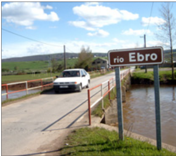
Tramo de la plataforma de Bolmir a Requejo.
