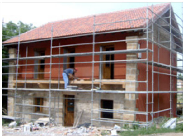
Reforma de un edificio en Orzales.
