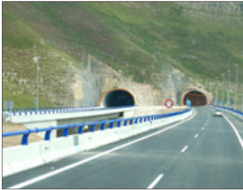
Doble túnel de la autovía.
