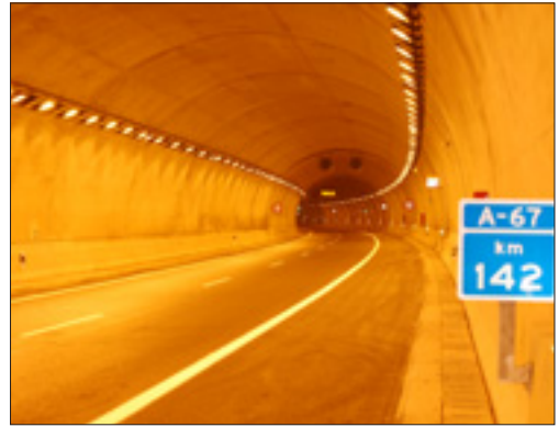
Interior de un túnel.
