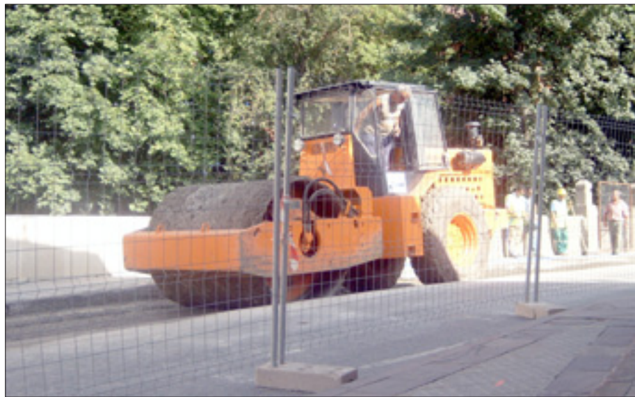
Obras en el Puente Carlos III.
