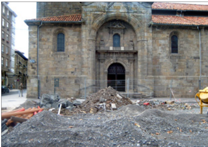
Una de las obras que acomete el Ayuntamiento de Reinosa.
