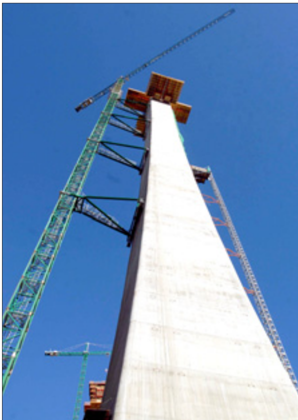
Uno de los pilares del viaducto de Montabliz.
