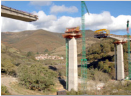
Obras del viaducto de Montabliz.
