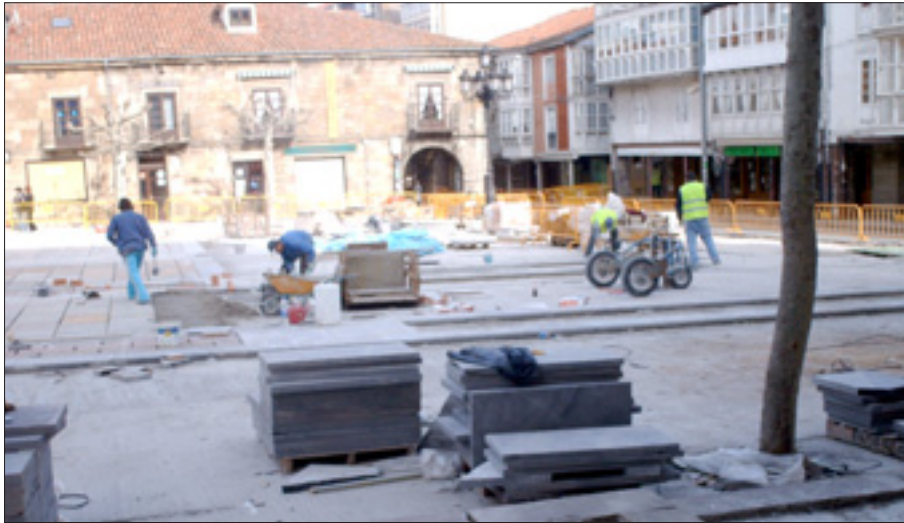
Estado de las obras de la Plaza de España el pasado lunes.
