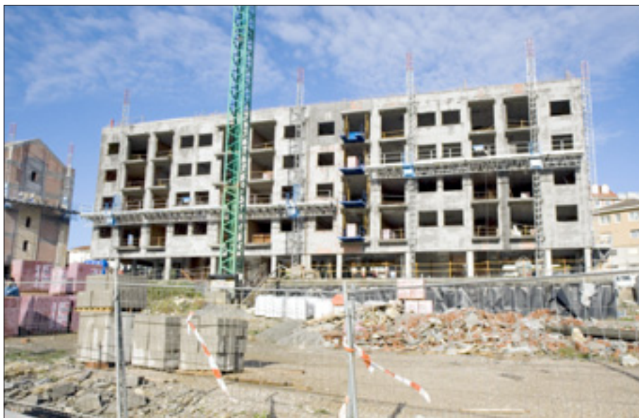
Edificios en construcción en Santander.
