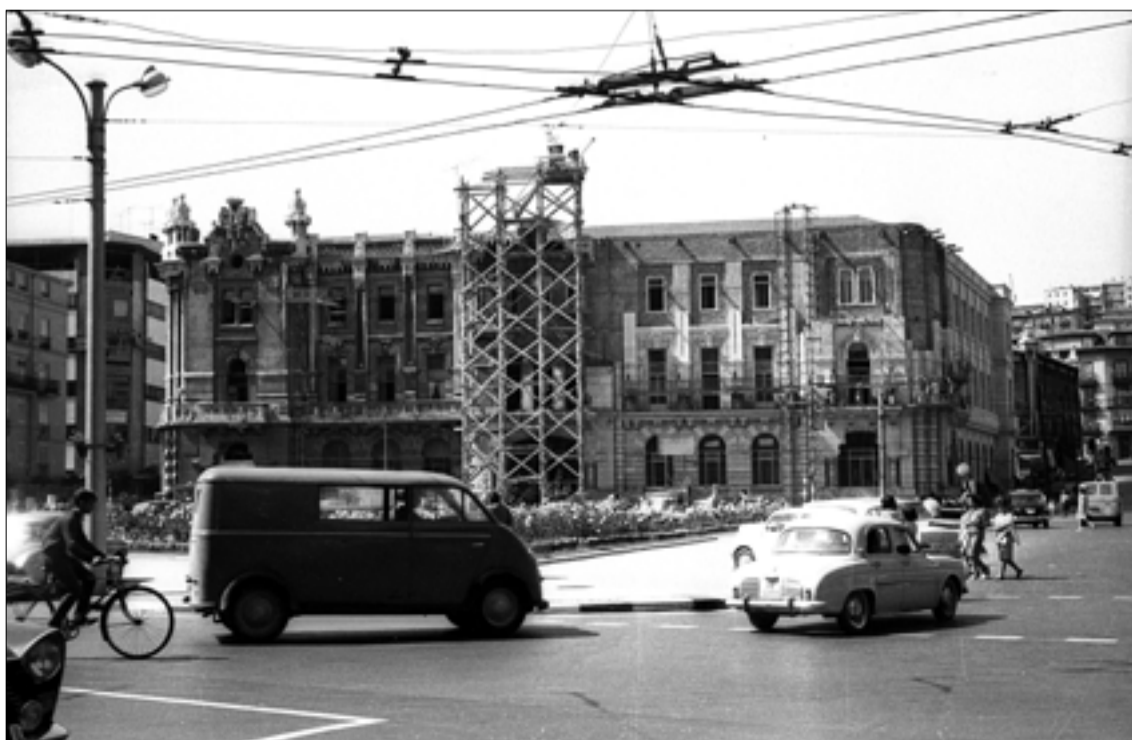
Obra en el Ayuntamiento para colocar la torre del reloj.
