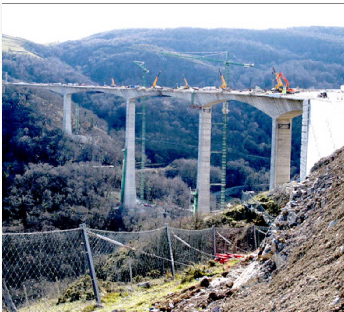
Las obras del viaducto de Montabliz que tiene 705 metros de longitud y 145 de altura máxima.
