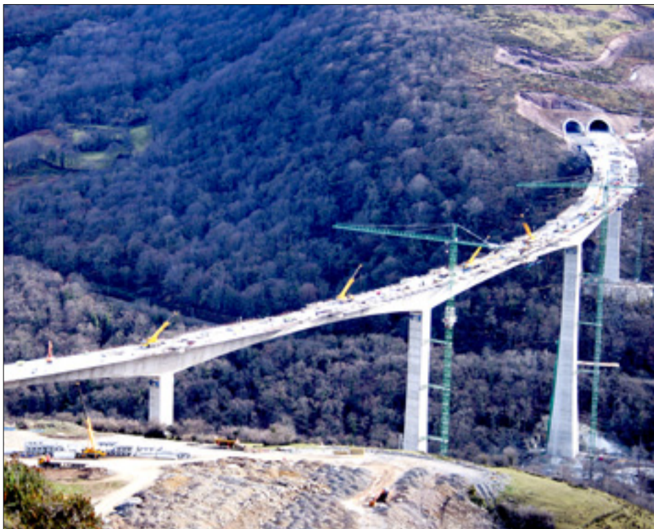
Las obras del viaducto de Montabliz dentro del tramo Molledo-Pesquera.
