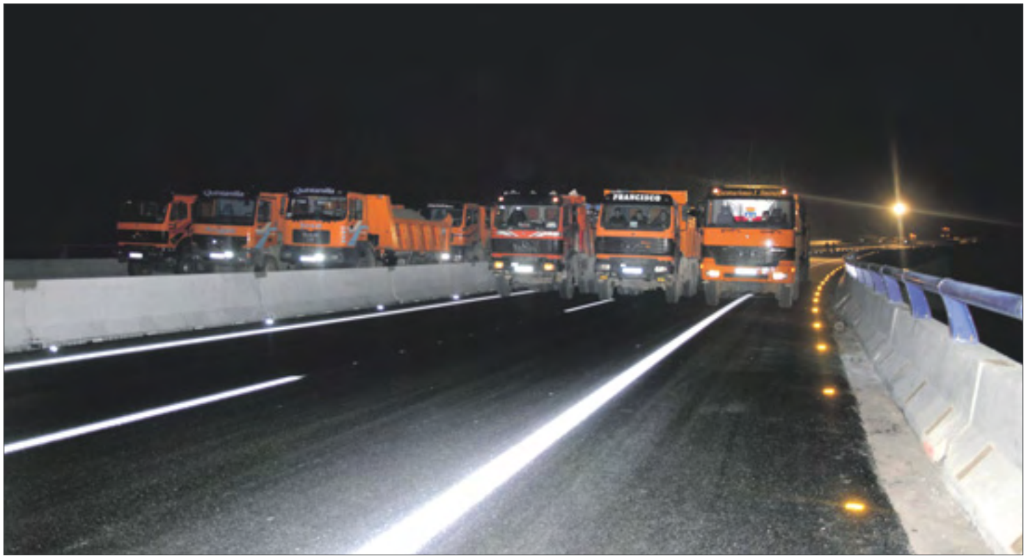
Un grupo de camiones avanza por el viaducto anoche, al comenzar las pruebas de carga.
