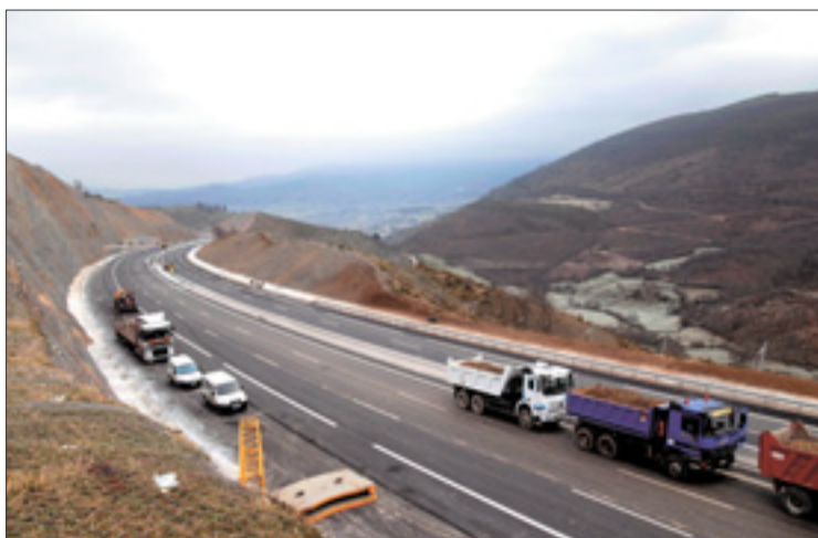
El tramo entre Molledo y Pesquera se abrirá hoy al tráfico.
