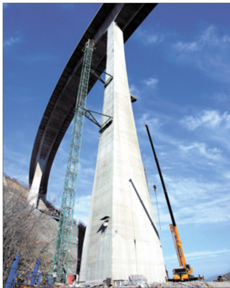
La enorme pila de hormigón que sustenta el viaducto de Montabliz.
