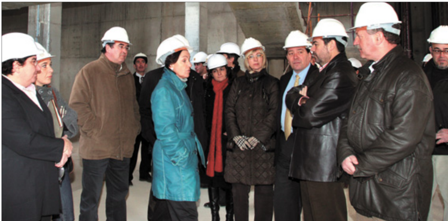
Gorostiaga, junto a Reyes Mantilla, Truan, Agudo y Barrio en el interior de las obras del Hospital Tres Mares de Reinosa. / ALERTA
