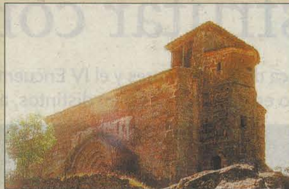
3 ALBACASTRO Se conserva entera, tiene el ábside recto y se eleva sobre un promontorio rocoso.
