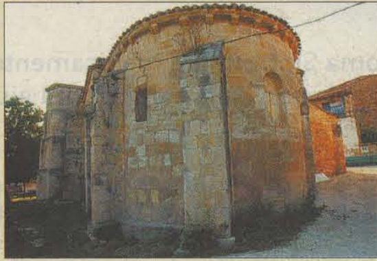
7 MANZANEDO Conserva toda la estructura. Destacan las arcadas del interior del ábside.
