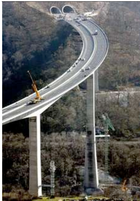
El viaducto de Montabliz, el más alto de España, con 145 metros. EFE
