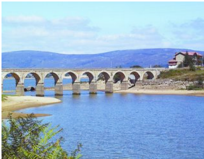
El municipio verá solucionado el problema de abastecimiento de agua.
