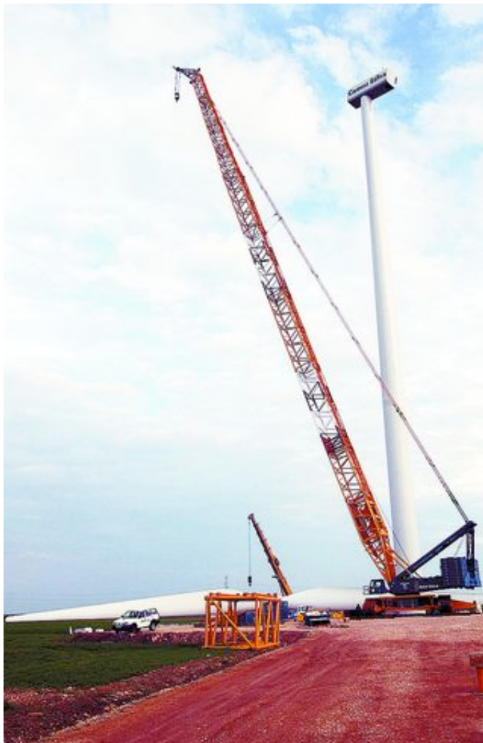
Maniobras para la instalación de un aerogenerador. Rodrigo Macho
