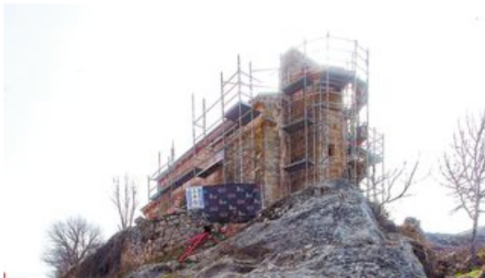
La iglesia de Albacastro, tras años de olvido, luce ahora en todo su esplendor tras las obras de consolidación y restauración ejecutadas.
