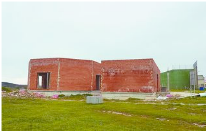
Estado actual del nuevo edificio donde se ubicará el Museo del Petróleo. diariodeburgos.es.
