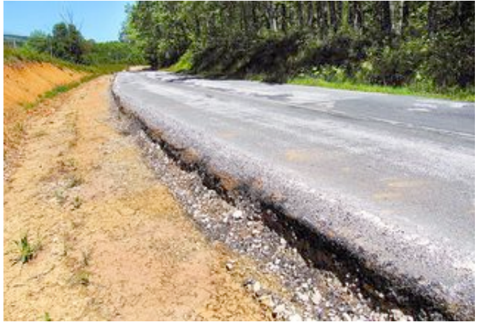
Los escalones laterales, la falta de señalización horizontal y el mal estado del firme complican el tránsito por la BU-526. A.C.
