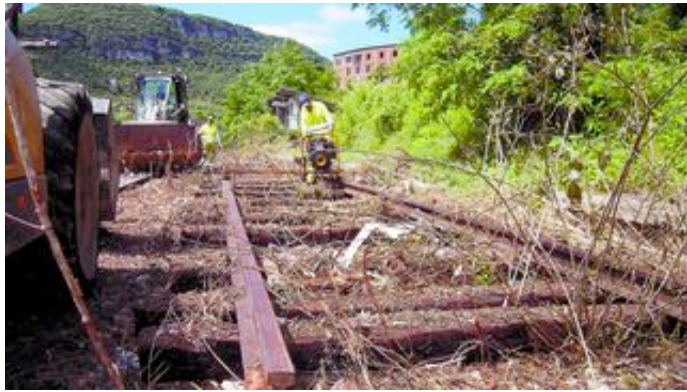
Un equipo de operarios está realizando los trabajos de desmantelamiento de la vía en Oña y localidades cercanas.
