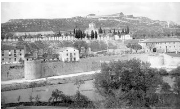
Uno de los capítulos analiza a los autores de las fotografías. En la imagen, el paseo de los Cubos con el cementerio al fondo, de Vadillo.
