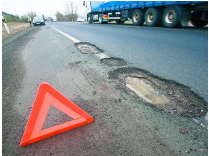
Socavones como estos aparecieron en la N-I el pasado invierno y causaron decenas de averías y siniestros.
