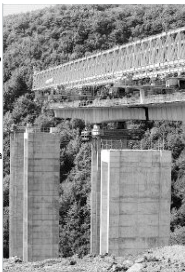
MOLLEDO-PESQUERA. Obras en la Autovía de la Meseta. / J. L. R.
