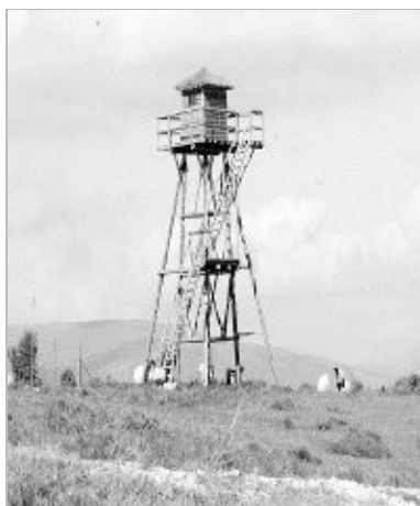
PROYECTO. Torre de control en La Lastra. / SANE
