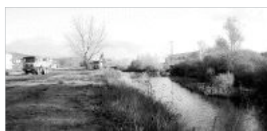
LIMPIEZA. El cauce del Híjar está siendo despejado de la espesa vegetación que tiene. / SERGIO DIEZ
