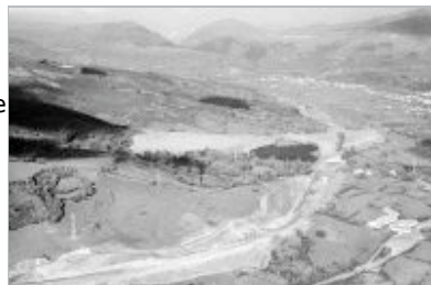
MOLLEDO. Imagen del estado de las obras del tramo de la autovía que en su día será la continuación por Molledo hacia Pesquera. / HÉLICE
