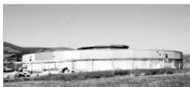
DETERIORO. Las instalaciones ganaderas se encuentran actualmente en situación de evidente abandono. / S. D.
