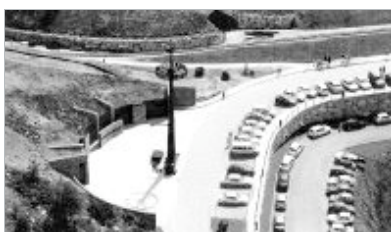
INTEGRACIÓN. El edificio destinado al turismo de aventura se integra en el desnivel del terreno, como un pliegue más / DM
