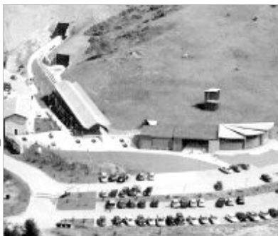
RECEPCIÓN DE VISITANTES. Los materiales son piedra de escombrera, acero oxidado y vidrio. / DM
