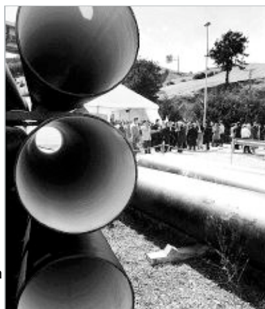
TUBERÍAS. Inicio de las obras de la Autovía del Agua. / A. F.
