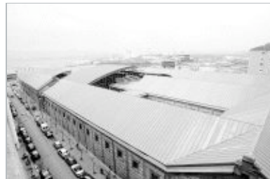
REHABILITACIÓN. Imagen actual del edificio de la Tabacalera de la calle Marqués de la Hermida donde se ubicará el archivo. /CELEDONIO
