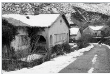
El Centro de Interpretación del Ferrocarril Santander-Mediterráneo se asentará en las tres viviendas de los directivos de la empresa Portolés que construyó el túnel de La Engaña. / DM
