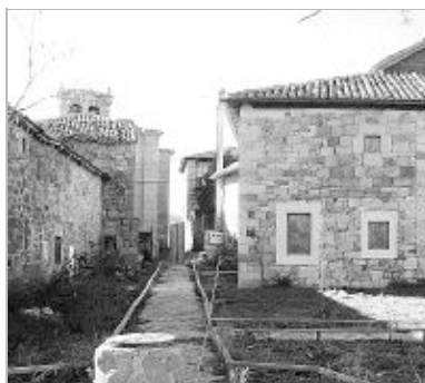
A la derecha, instalaciones del futuro centro de interpretación en La Puente del Valle / SARDINA
