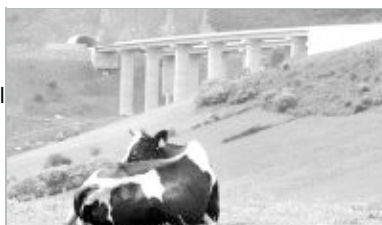
Imagen de la boca norte del túnel de Lantueno y de los dos tableros de los viaductos que, por la derecha, empalmarán con el puente de Santiurde. / ANDRÉS FERNÁNDEZ
