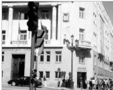
El museo ocupa parte de los bajos de la sede, pero da al conjunto la protección máxima correspondiente a los monumentos históricos. / DM
