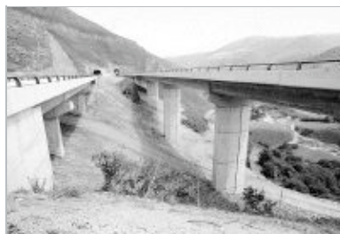
Los viaductos caracterizan al tramo entre Pesquera y Reinosa. / M. DE LAS CUEVAS
