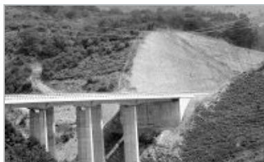
Las obras del tramo de la autovía tiene medidas correctoras del entorno natural. / M. DE LAS CUEVAS
