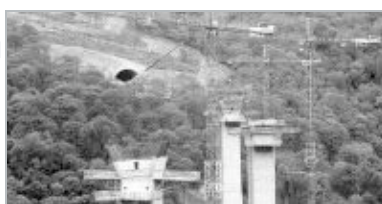
El viaducto de Montabliz sorteará el valle del Bisueña mediante cuatro pilas, continuando luego la traza de la por el túnel de Somaconcha. / MIGUEL DE LAS CUEVAS
