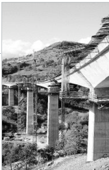
El viaducto de Pujayo está muy avanzado. / M. DE LAS CUEVAS
