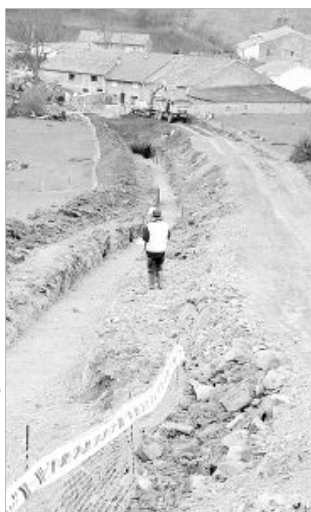
En Lantueno se está construyendo un depósito de almacenamiento con una capacidad de 250 metros cúbico. / FOTOS: J. L. SARDINA
