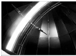
Detalle de las instalaciones. / J. L. S.
