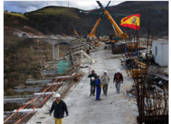
La bandera de España ondea sobre el viaducto, en cuyo tablero se trabaja a tres turnos. / ANDRÉS FERNÁNDEZ
