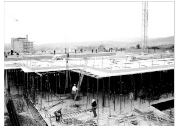
Estado de las obras del nuevo Hospital Tres Mares, en Reinosa. / S. D.
